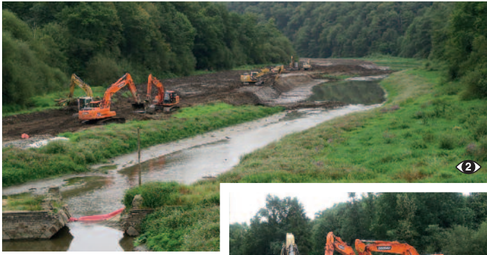
Travaux de curage terrestre et stockage dans l'emprise du lit majeur au niveau de l'ancien pont de la République. Photo © DDTM50/MBS
